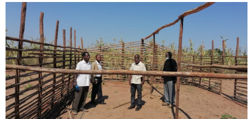
Baubeginn der Kirche.
