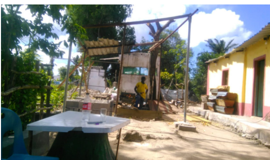
Hier entsteht die Werkstatt
