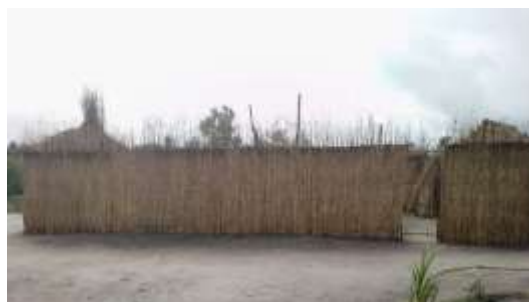
Eine neue wird errichtet
